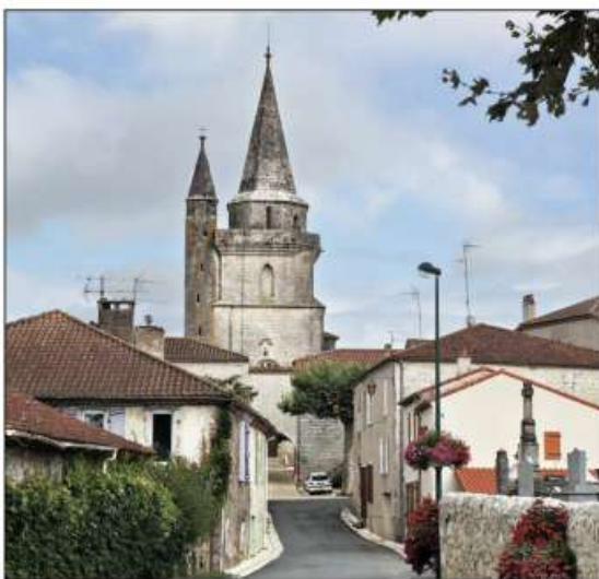
Élévation extérieure- Façade Ouest
